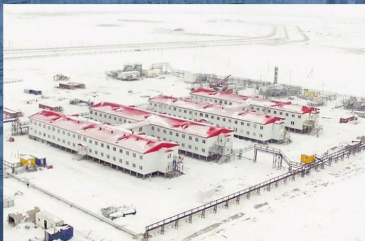
ОБУСТРОЙСТВО ВРЕМЕННОГО ВАХТОВОГО ЖИЛОГО КОМПЛЕКСА (ВЖК)
