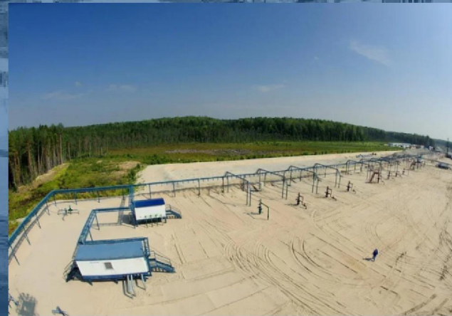
ОБУСТРОЙСТВО КУСТОВЫХ ПЛОЩАДОК
